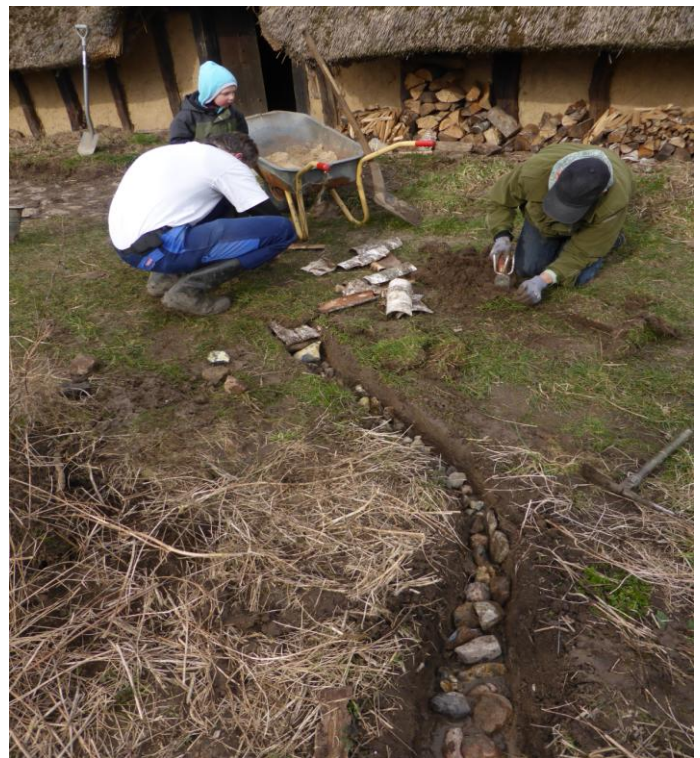
Strøm tilsluttes af autoriseret elektriker
